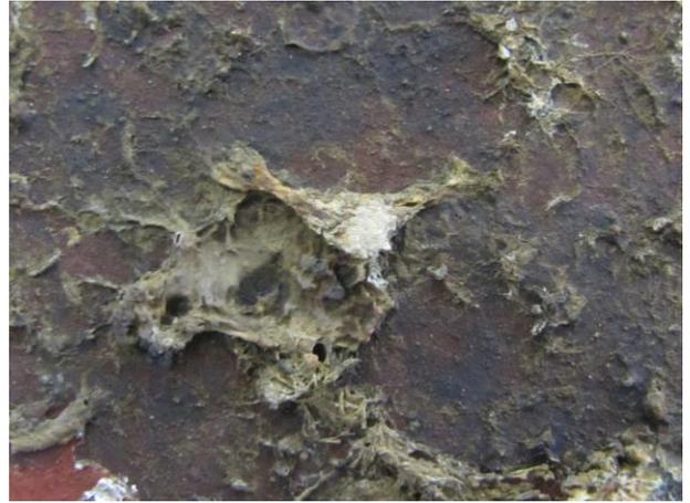
図11 船底部の鋼板の付着生物跡 No.3
