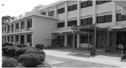
環境材料工学科棟
